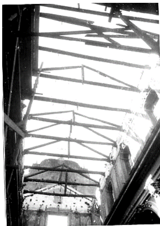
Fig. 8 - La volta in legno distrutta
