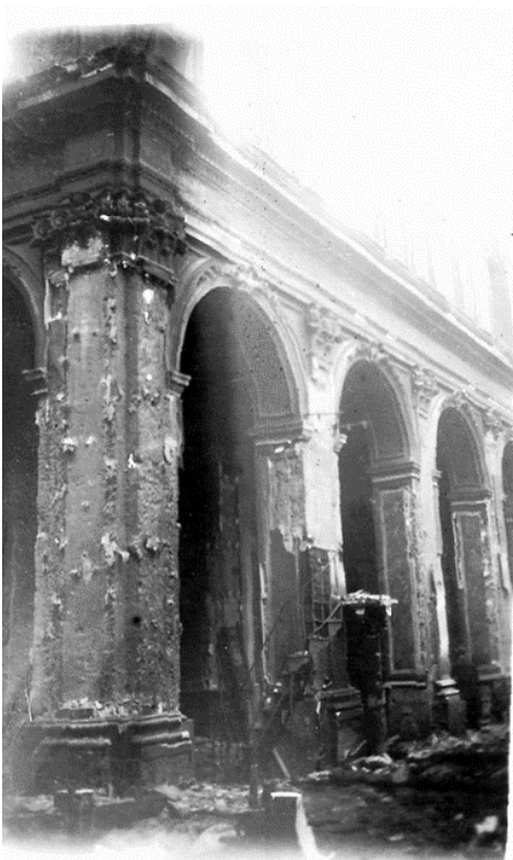
Fig. 12 – I resti carbonizzati del pulpito e le colonne rovinate, di cui si intravede la struttura grezza
